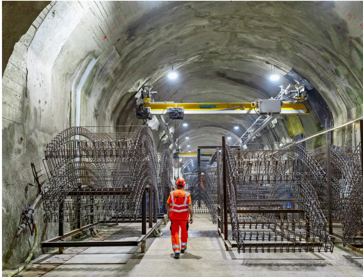
Armierungen für die Betonelemente werden in der unterirdischen Betonkaverne hergestellt. Bilder: Urs Flüeler/Keystone (Göschenen, 27. 7. 2026)
