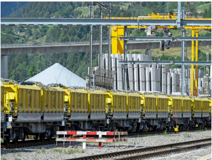
Ein Teil des Tunnelausbruchmaterials gelangt nach Flüelen.
